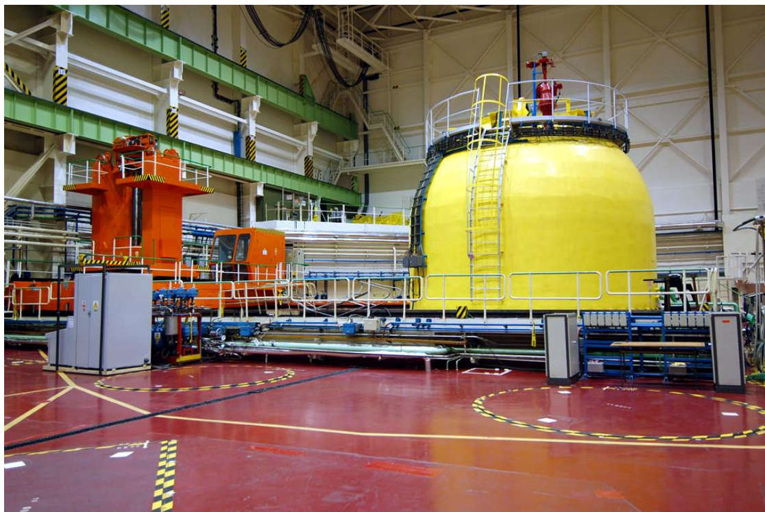
Obr. č. 86. JE V1 – Zavážací stroj (vľavo) a kryt reaktora (vpravo)
