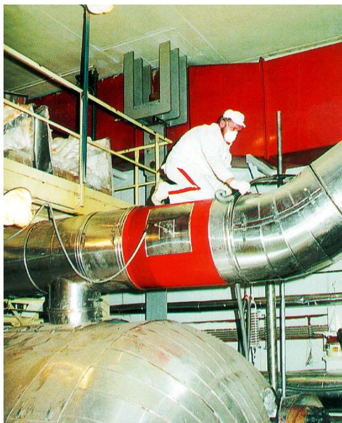
Obr. č. 97. JE V1 – Práce v boxe parogenerátora
