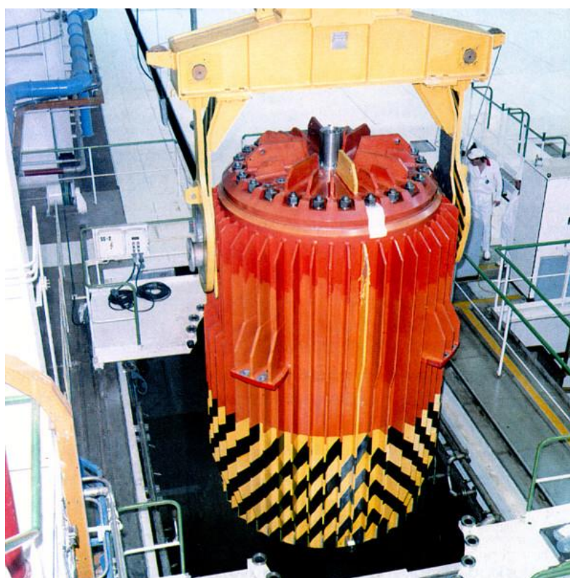
Obr. č. 90. JE V1 – Kontajner na vyhoreté jadrové palivo
