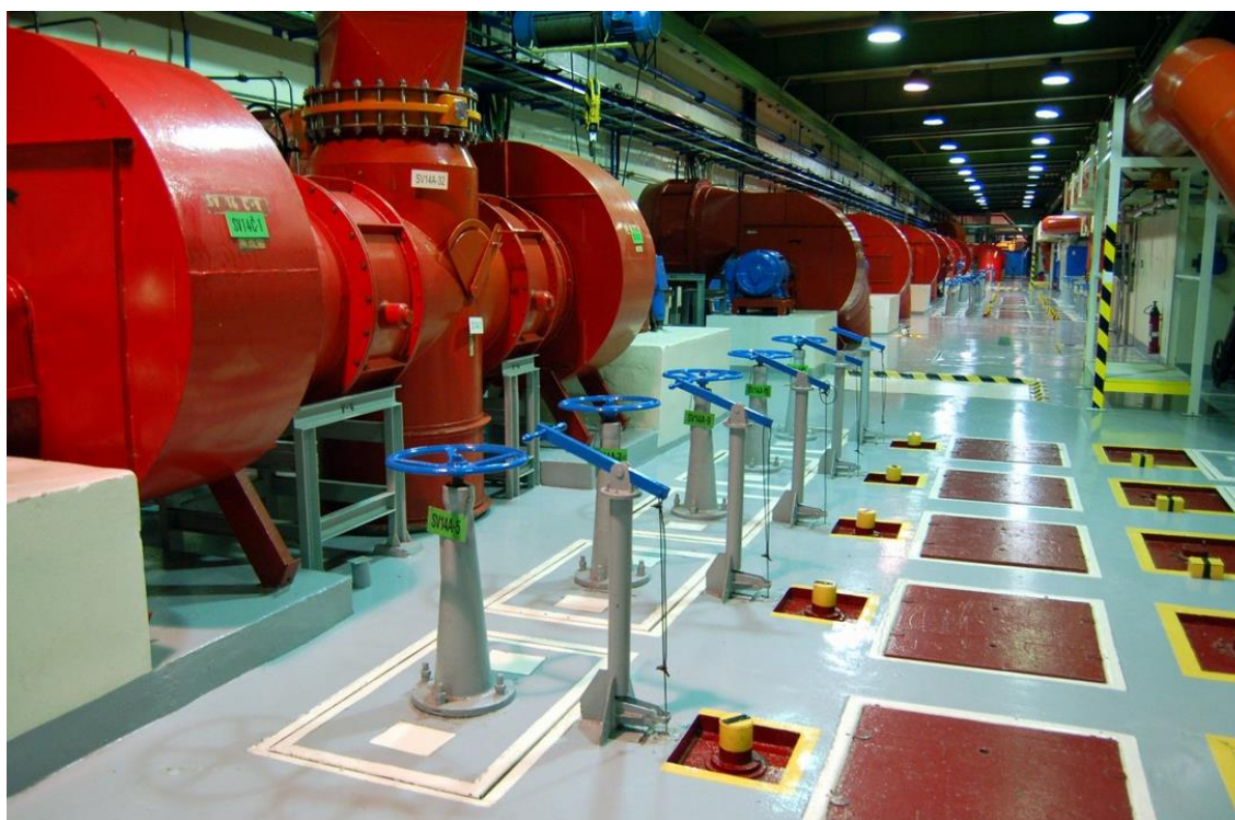
Obr. č. 98. Vzduchotechnické systémy – vybrané zariadenia
