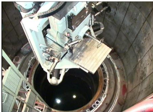
Obr. č. 48. Zavedenie rezacieho nástroja a vnútorné rezanie
