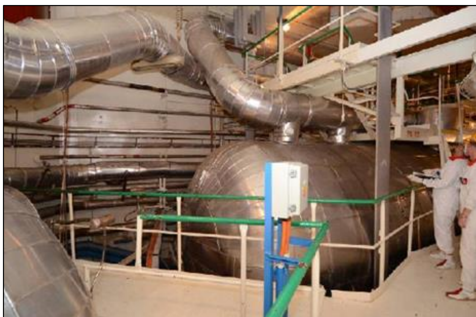
Obr. č. 24. Izolačný plášť PG
