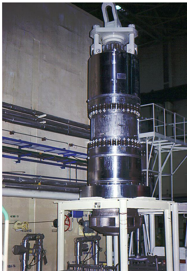
Obr. č. 92. JE V1 – Hlavné cirkulačné čerpadlo
