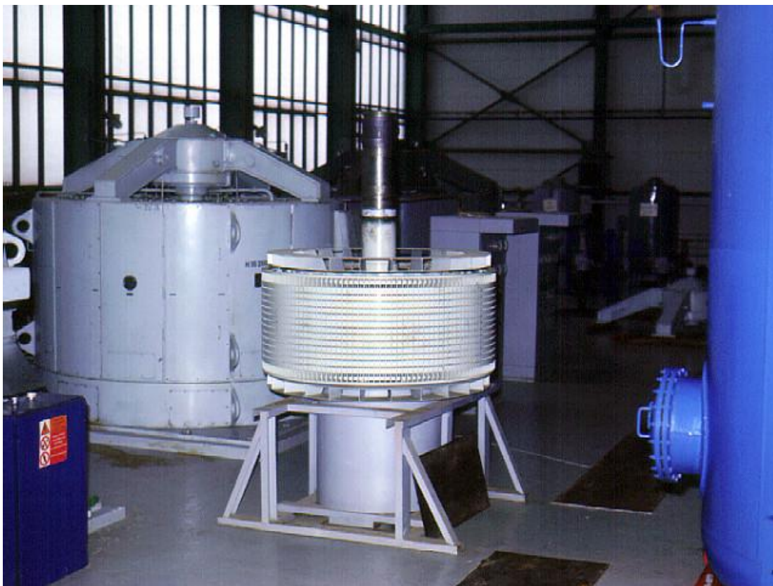
Obr. č. 83. JE V1 – Čerpadlá chladiacej vody v centrálnej čerpacej stanici
