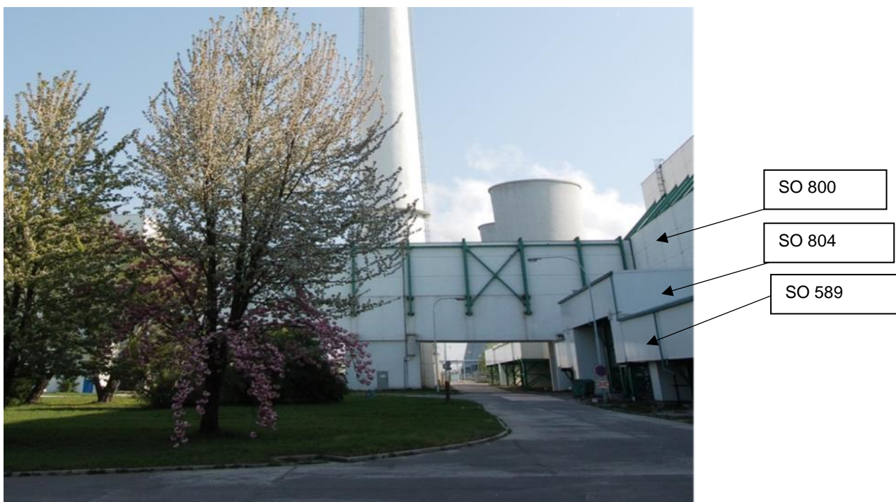
1.1.23 Obr. č. 105. JE V1 – budovy ktoré budú zdemolované v 2. etape; SO 800 Budova reaktorov JE V1, SO 589 Nadzemný kolektor technickej vody, 1. a 2. podsystém V1, SO 804 Spojovací most 800-801 V1
