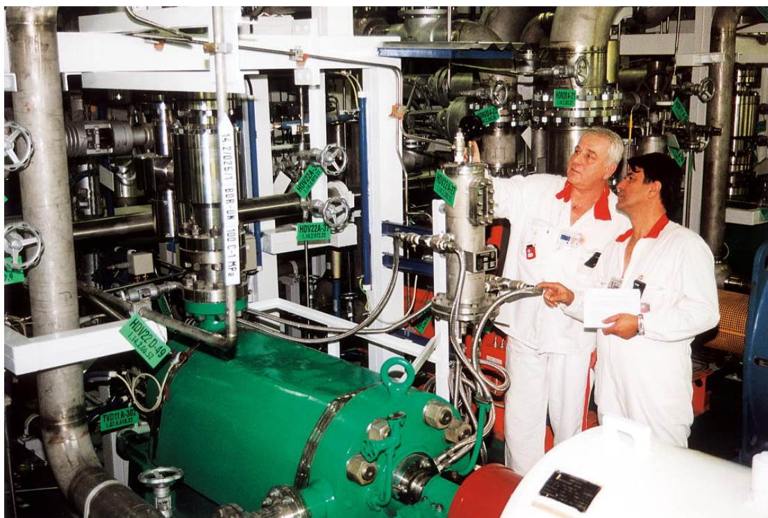
Obr. č. 99. JE V1 - Kontrola vybraných zariadení
