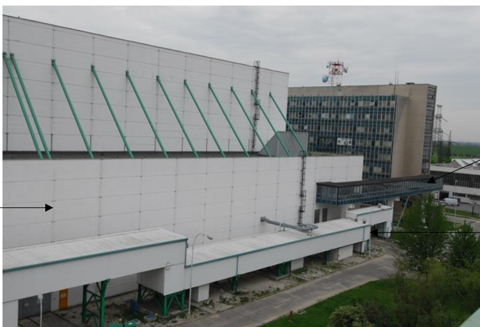
1.1.22 Obr. č. 104. JE V1 - budovy ktoré budú zdemolované v 2. etape; SO 800 Budova reaktorov JE V1, SO 803 Prevádzková budova – budova - most 631-803 a 803-800, SO 589 Nadzemný kolektor technickej vody 1. a 2. podsystém V1
