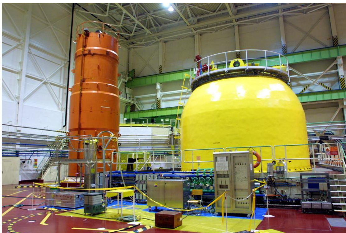
Obr. č. 87. JE V1 – Kryt reaktora v reaktorovej sále V1
