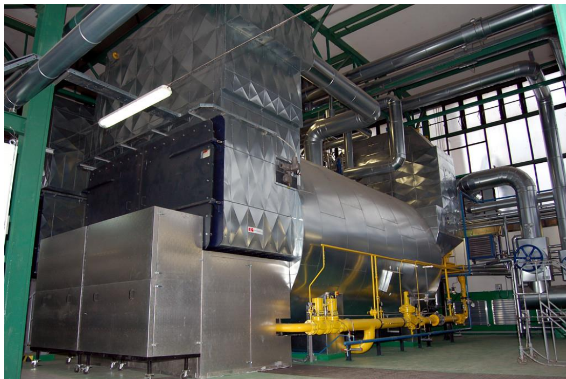
Obr. č. 102. JE V1 Rezervná a nábehová kotolňa - veľký zdroj znečisťovania ovzdušia (predpoklad prevádzky do r. 2023)
