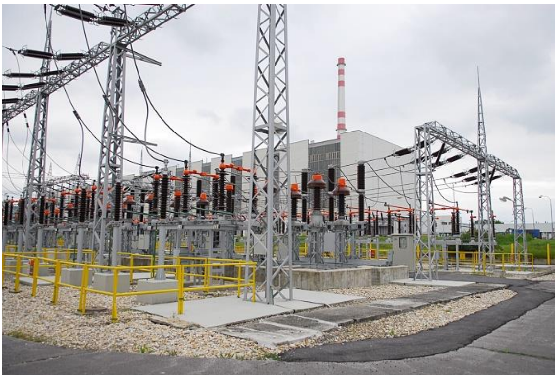
Obr. č. 101. Transformátorová stanica 110 kV (bude rekonštruovaná)
