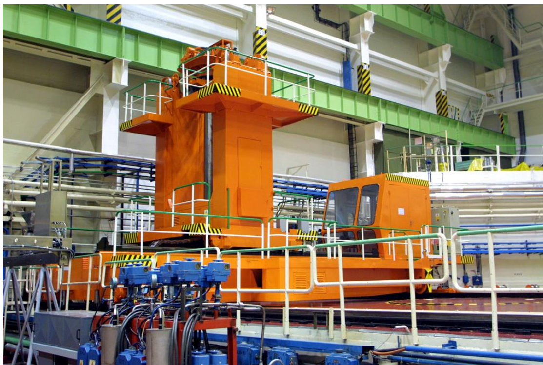
Obr. č. 89. JE V 1 - Zavážací stroj pri výmene paliva
