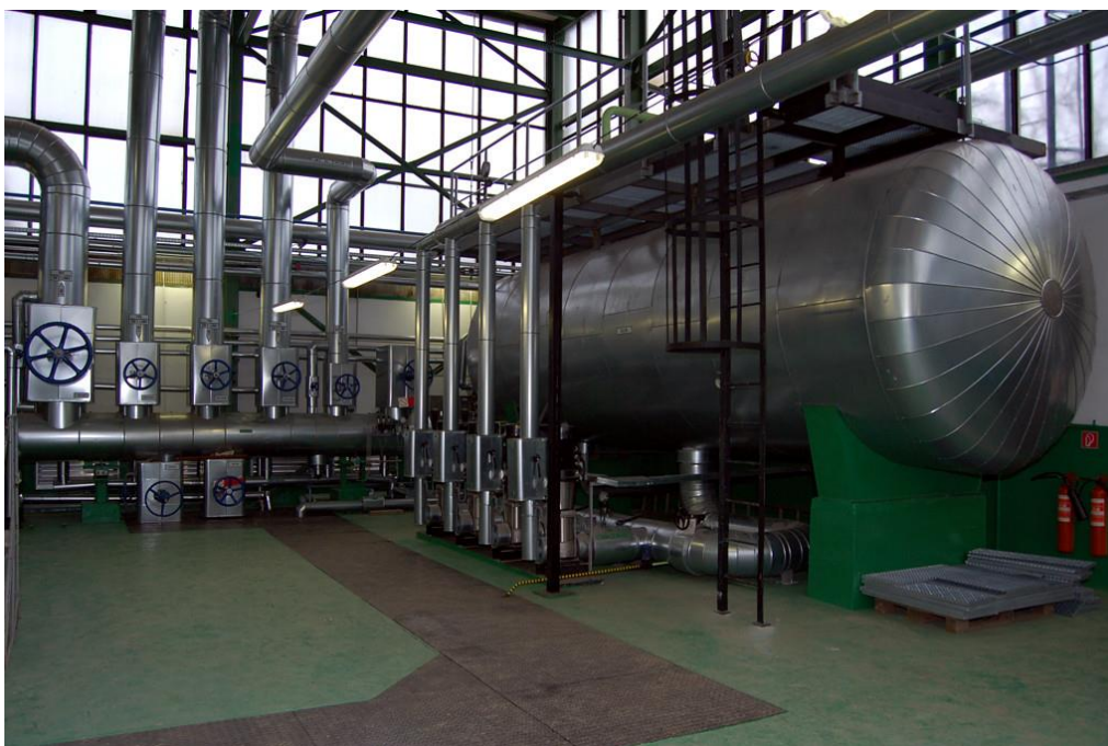
Obr. č. 103. JE V1 Rezervná a nábehová kotolňa - veľký zdroj znečisťovania ovzdušia (predpoklad prevádzky do r. 2023)
