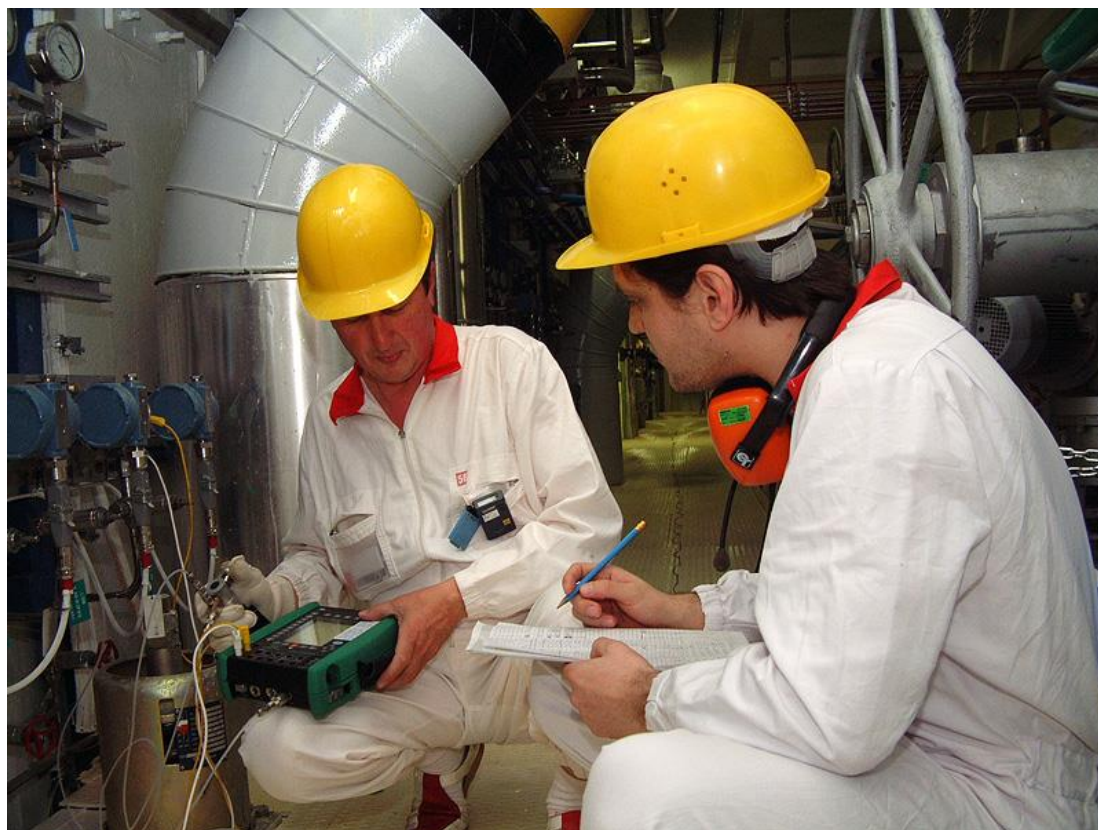
Obr. č. 100. Kontrola vybraných zariadení
