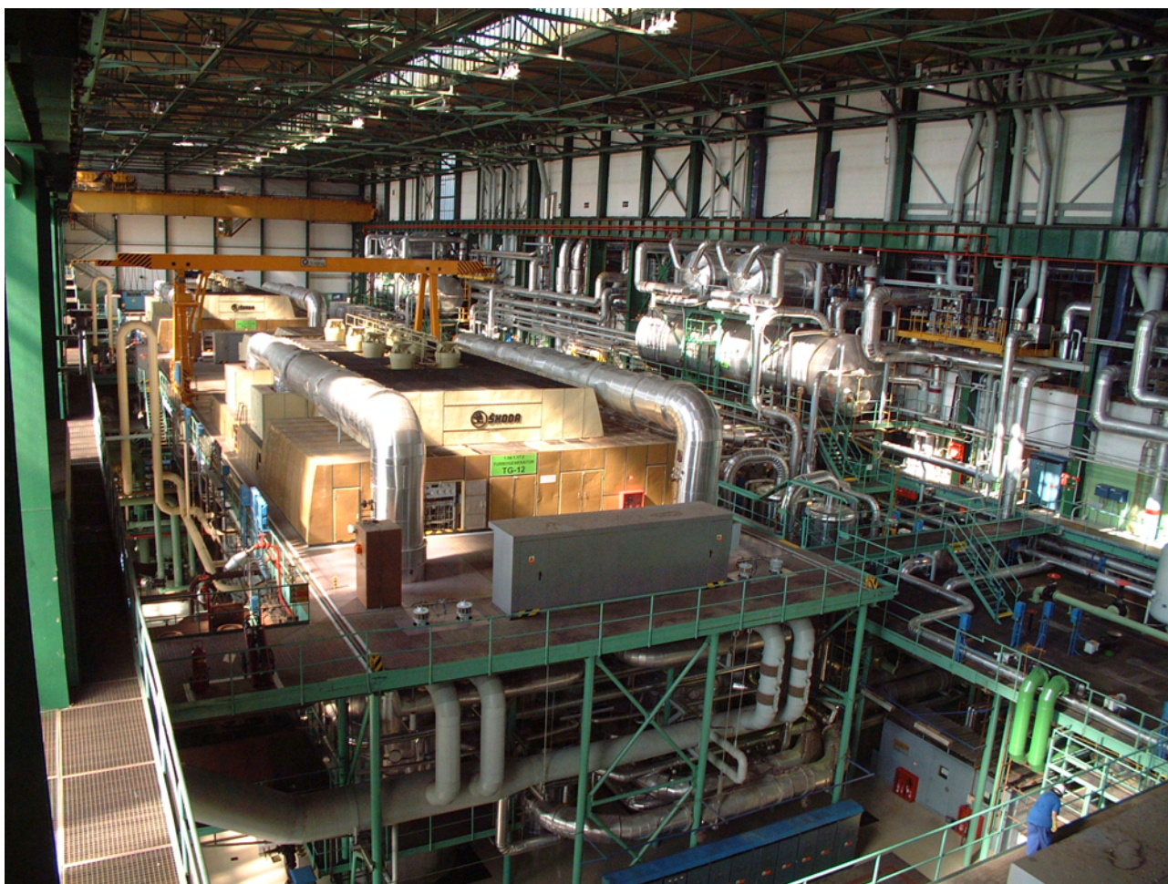
Obr. 5: Pohľad do strojovne JE V1
