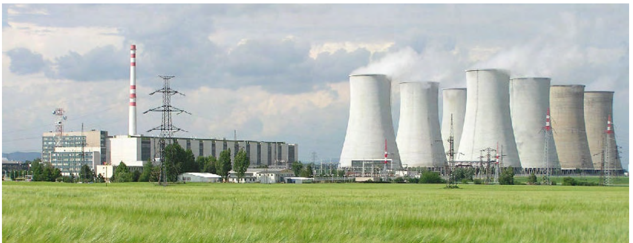
Obr. 2: Pohľad na JE V1 z juhovýchodu
