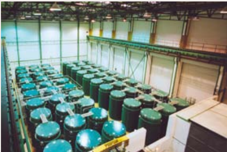
Suchý spôsob skladovania vyhoreného jadrového paliva
