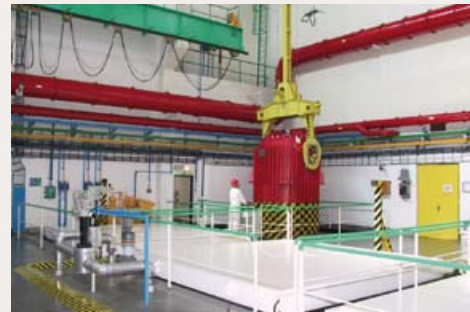
Transport kontajnera TK C-30 s vyhoreným jadrovým palivom
