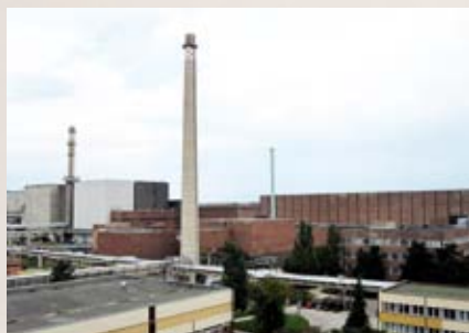
V Greifswalde boli inštalované tlakovodné reaktory typu VVER.
