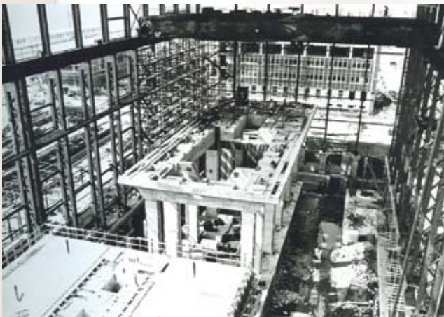
Buduje sa strojná, kde budú umiestnené turbogenerátory.
