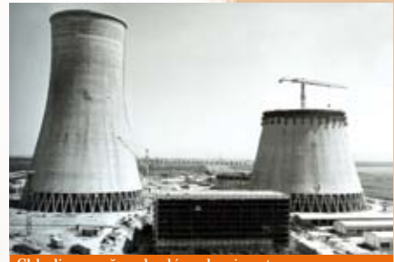
Chladiace veže – budúce dominanty jaslovskobohunického jadrového komplexu.
