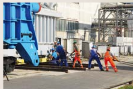
Nový majiteľ päť blokových transformátorov na vlastné náklady a vlastnými kapacitami demontoval a odviezol z areálu JE V1.
