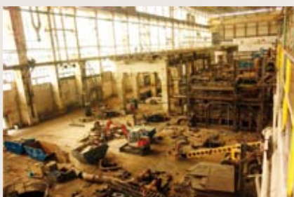
Demontáž zariadení v strojovni.
