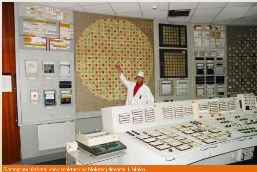
Kartogram aktívnej zóny reaktora na blokovej dozorni 1. bloku.
