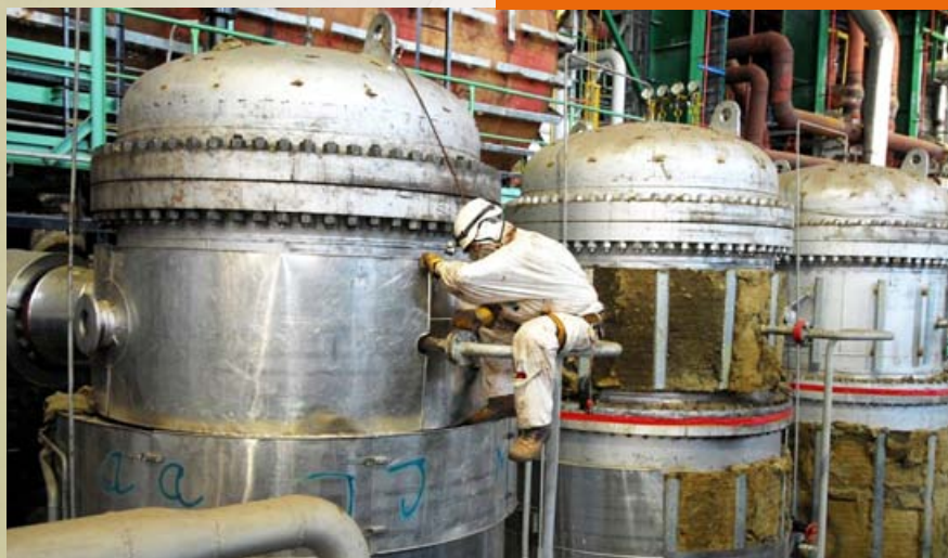
Odstraňovanie izolácií zo zariadení v strojomni V1.
