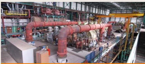
V súčasnosti sú zariadenia pripravené na postupnú demontáž.
