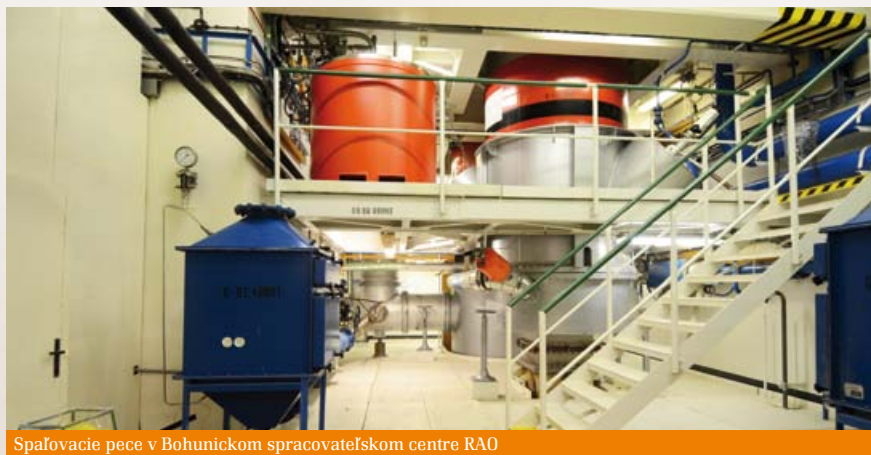
Spaľovacie pece v Bohunickom spracovateľskom centre RAO
