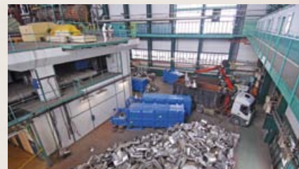
Separované kovové časti izolácií sa ukladali do kontajnerov.
