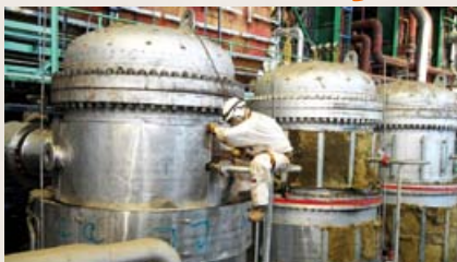
Demontáž izolácií bola veľakrát spojená s prácou vo výškach.
