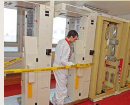
Montáž personálnych monitorov povrchovej kontaminácie.
