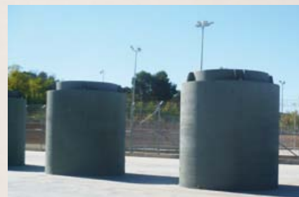
Dočasné skladovanie vysoko aktívnych RAO a vyhoreteho jadrového paliva pri JE Jose Cabrera.
