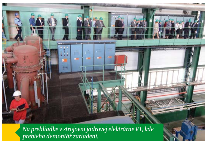
Poslanci Európskeho parlamentu na blokovej dozorni jadrovej elektrárne V1
