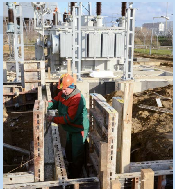
Príprava debnenia pre betonáž
