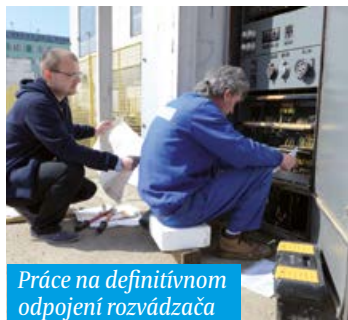
Demontážne práce v 220 kV rozvodni 1. bloku pokročili.
