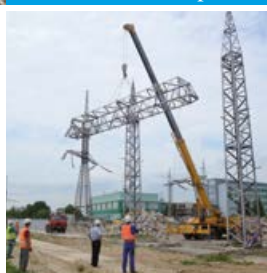
Demontáž hraničného portálu 220 kV linky V074
