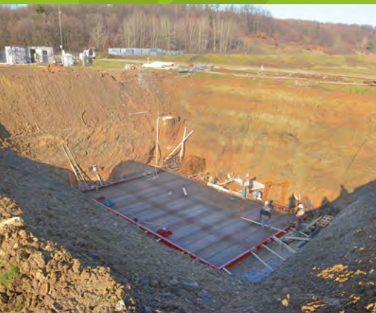
V novembri sa začala výstavba úložiska pre veľmi nízko aktívne RAO.
