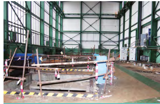
Po demontáži zariadení v centrálnej čerpacej stanici chladiacej vody bude nasledovať jej demolácia.
