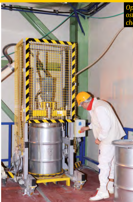
Fixačné zariadenie na zafixovanie načerpaných ionexov a kalov v 200 l MEVA sude do SIAL matrice.
