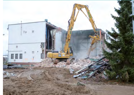
Vo fáze realizácie je projekt demolácie dieselgenerátorovej stanice.
