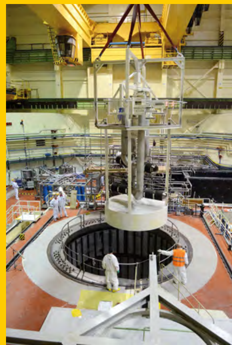
Zavážanie prepojovacieho zariadenia – „pavúka“ do reaktora.
