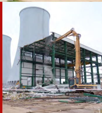
Demolácia čerpaciej stanice JE V1
