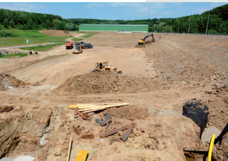
V mochovskom areáli úložiska pre nízko aktívne RAO sa buduje úložisko pre veľmi nízko aktívne RAO.
