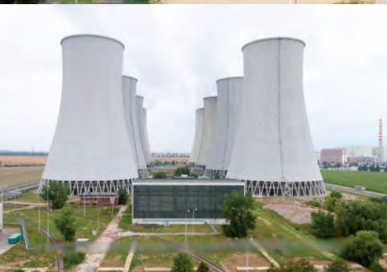
Centrálna čerpacia stanica chladiacej vody JE V1 pred realizáciou projektu BIDSF
