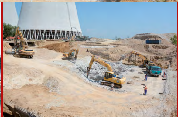
Odstraňovanie betónových základov čerpaciej stanice JE V1
