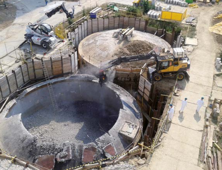
Vyradovanie neprevádzkovaných skladovacích nádrží čistiacej stanice odpadových vôd
