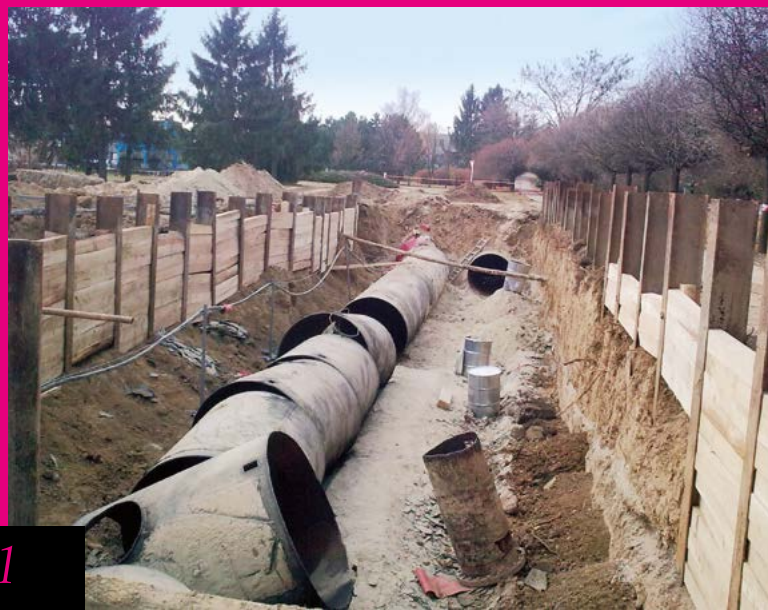
Odstraňovanie potrubí chladiacej vody
