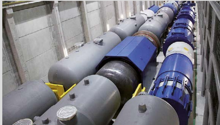
Cenné skúsenosti poskytuje vyradovanie ôsmich blokov s reaktormi VVER 440 v nemeckej JE Greifswald. Na snímke veľkorozmerné komponenty – parogenerátory v Integrálnom sklade RAO Nord EWN Greifswald.
