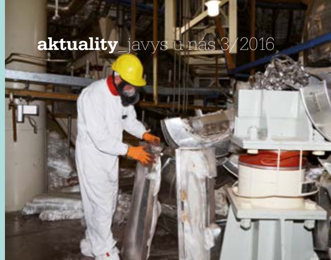
Jedným z realizovaných projektov BIDSF je demontáž izolácií v kontrolovanom pásme JE V1. Na snímke sú zdokumentované demontážne práce v boxe parogenerátorov.
