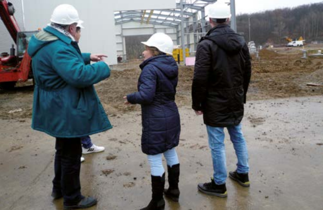
Technici bezpečnostno-technickej služby JAVYS, a. s., na jednej z kontrol na stavenisku manipulačnej budovy pre veľmi nízko aktívne RAO
