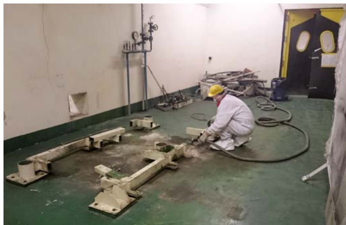
Zariadenie cementační linky po demontáži
