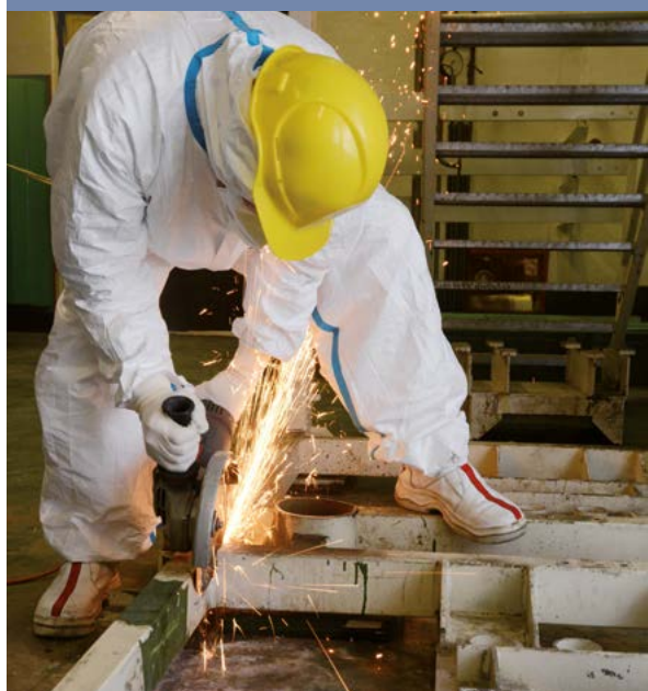
Fragmentácia rámu cementační linky
