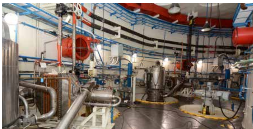
Jedným z realizovaných projektov v JE V1 je demontáž veľkorozmerných komponentov primárneho okruhu, medzi ktoré patria aj hlavné cirkulačné čerpadlá. • Foto: Rastislav Prítrský
