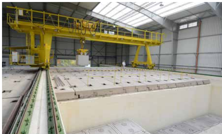
Finálne uloženie spracovaných a upravených RAO vo vláknobetónových kontajneroch do Republikového úložiska RAO v Mochovciach. • Foto: Rastislav Prítrský
