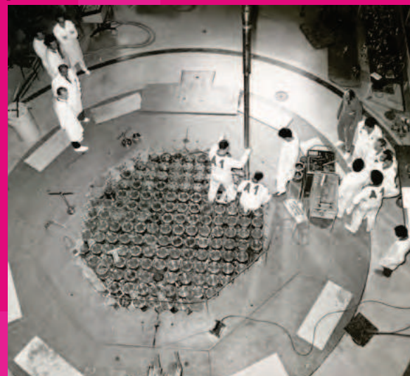
Príprava palivových článkov pred zavázaním do reaktora.
