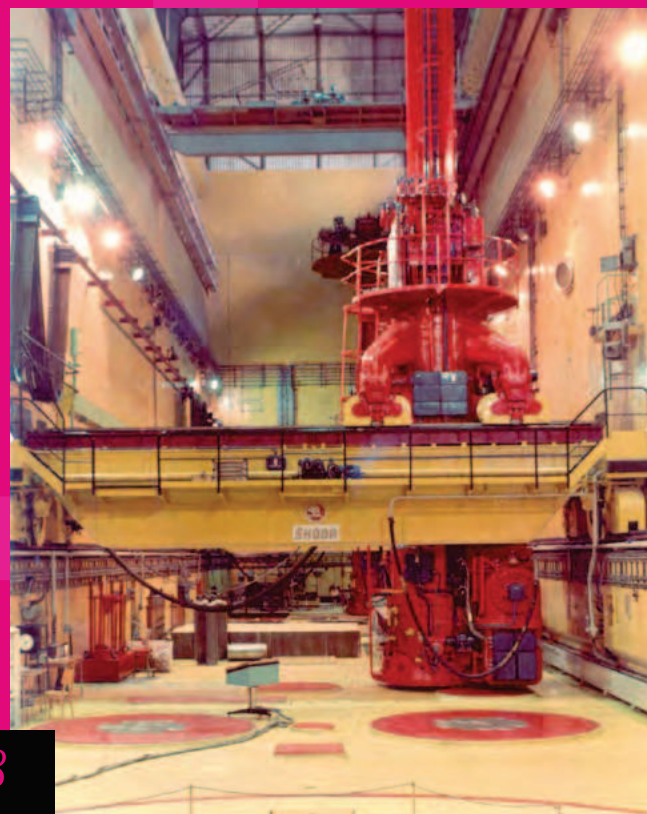
Reaktorová sála so zavážacím strojom
