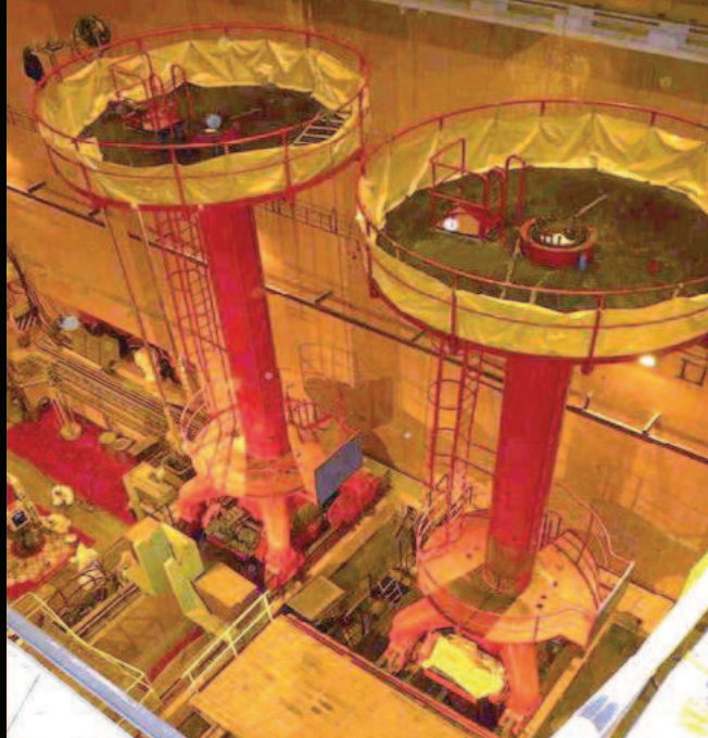
Zavážacie stroje v reaktorovej sále pred vyradovaním
