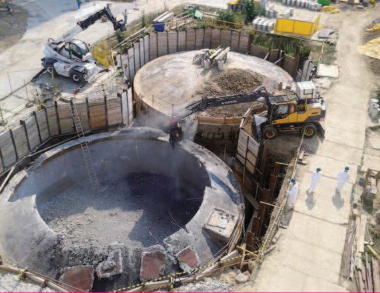
Vyraďovanie neprevádzkovaných skladovacích nádrží čistiacej stanice odpadových vôd
