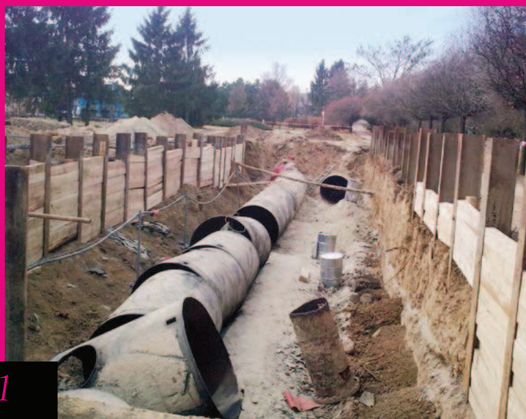
Odstraňovanie potrubí chladiacej vody
