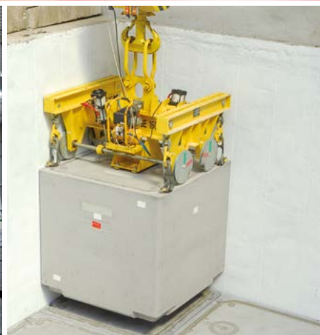
Ukladanie vláknobetónového kontajnera
