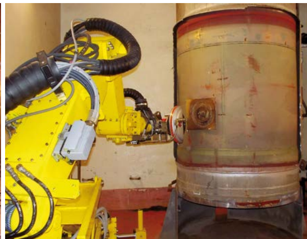
Fragmentácia odparovača ťažkej vody diaľkovo riadeným manipulátorom
