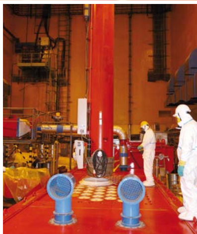
Zaväzanie hermetického puzdra s RAO do skladovacieho zariadenia
