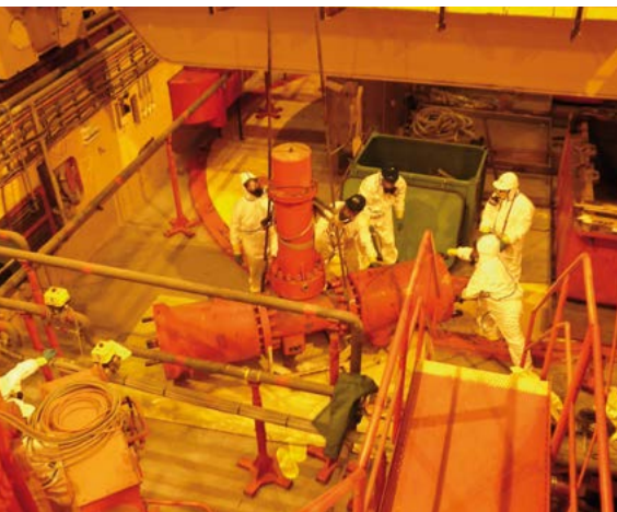
Vyradovanie turbokompresora záväžacieho stroja
