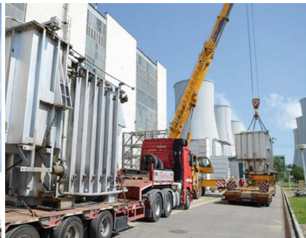
Demontáž transformátorov
