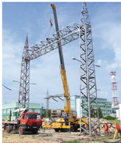
Demontážne práce v 220 kV rozvodni
