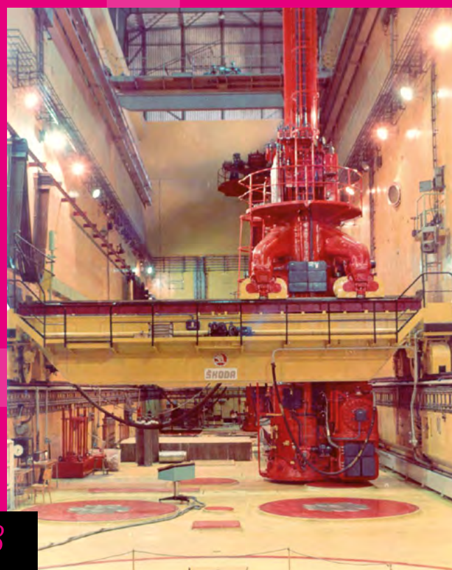
Reaktorová sála so zavážacím strojom
