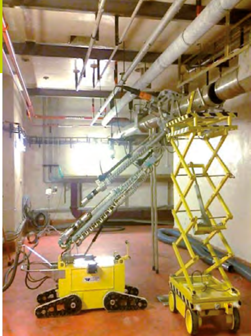
Fragmentácia potrubného systému ťažkej vody dialkovo riadeným manipulátorom
