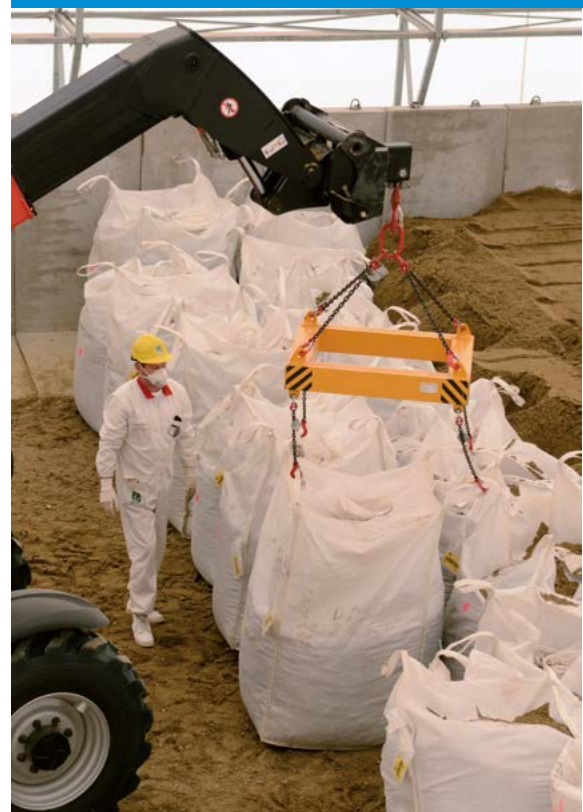
Ukladanie veľmi nízko aktívnych RAO v prvom module. Foto: Rastislav Prítrský
