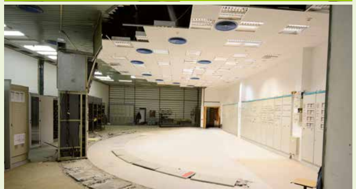
Priestory blokovej dozornej po demontáži signalizačných panelov a ovládacích pultov. Foto: Rastislav Pítrský
