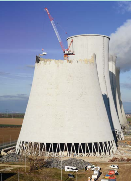
Demolácia prvej chladiacej veže napreduje.
