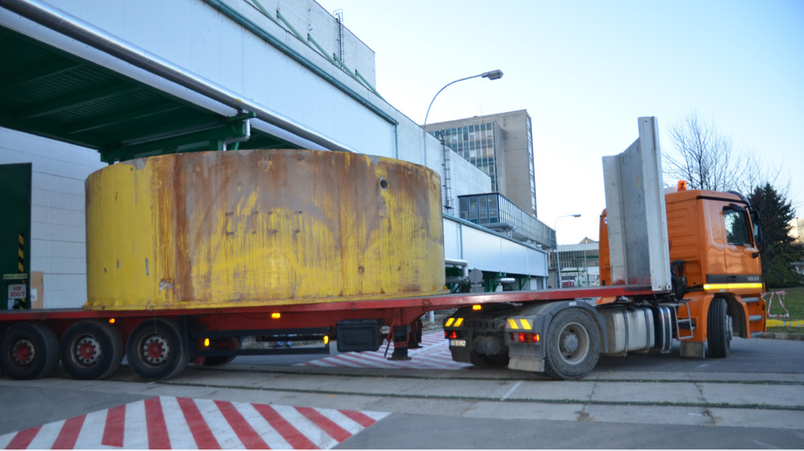
Transport fragmentu kolpaku z reaktora 1. bloku JE V1.
