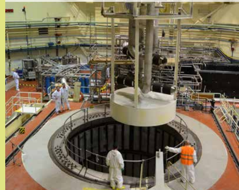
Zavážanie prepojovacieho zariadenia „pavúka“ do reaktora 2. bloku.
