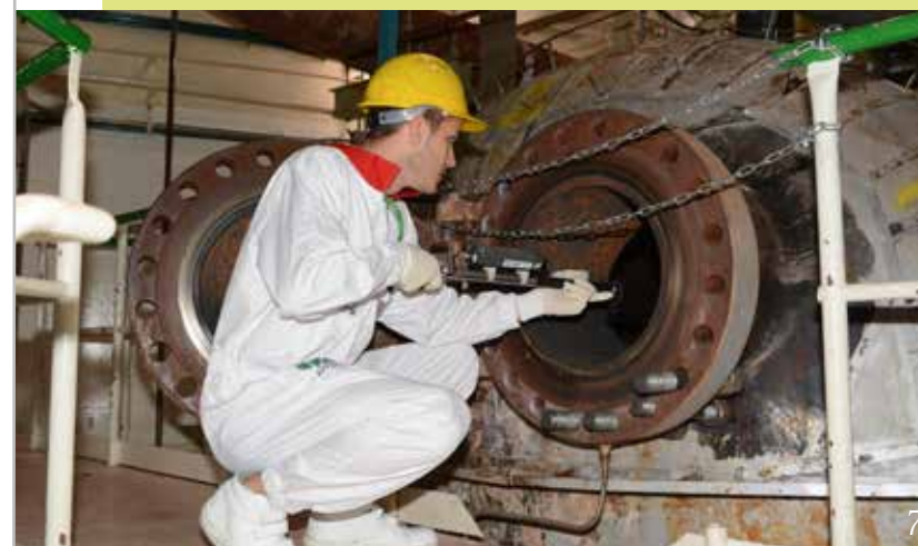
Monitorovanie dávkového príkonu v parogenerátore.
