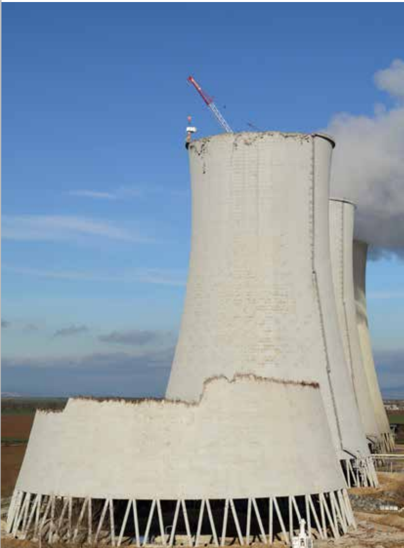
Odpad z chladiacich veží sa využije na spätné zasypenie jám.
