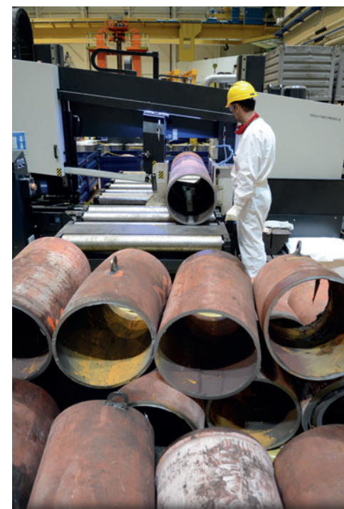
Rezanie potrubí parovodov na fragmentačnom pracovisku inštalovanom v reaktorovej sále.
