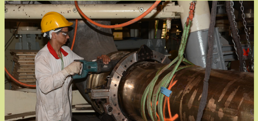
Hlavné cirkulačné čerpadlá v JE V1 zaistovali prietok chladiva cez aktívnu zónu reaktora. Na snímke orbitálna píla reže hlavné cirkulačné potrubie k hlavnému cirkulačnému čerpadlu, pričom je potrebné aj dorezávanie priamočiarou pílou.
