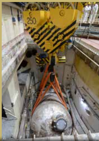
Zdemontovaný parogenerátor v boxe.
