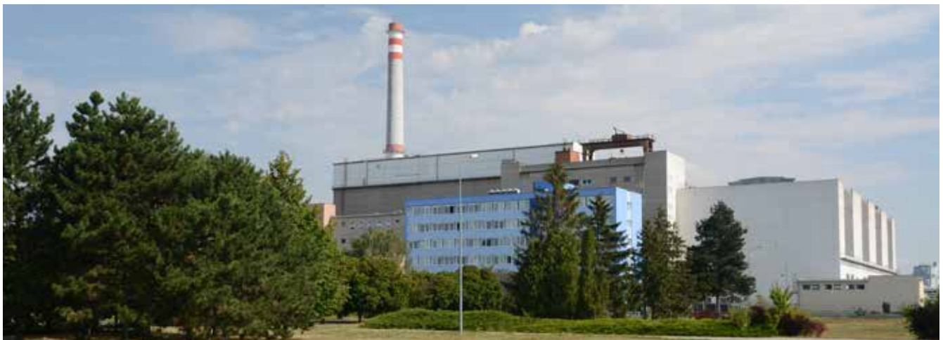
Vyradovaná jadrová elektráreň A1. • Foto: Rastislav Prítrský
