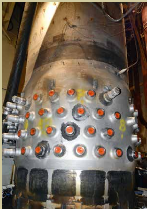
V rámci projektu Demontáž veľko-rozmerných komponentov primárneho okruhu sú v JE V1 demontované a fragmentované elektrické ohrievače z dvoch kompenzátorov objemu.
