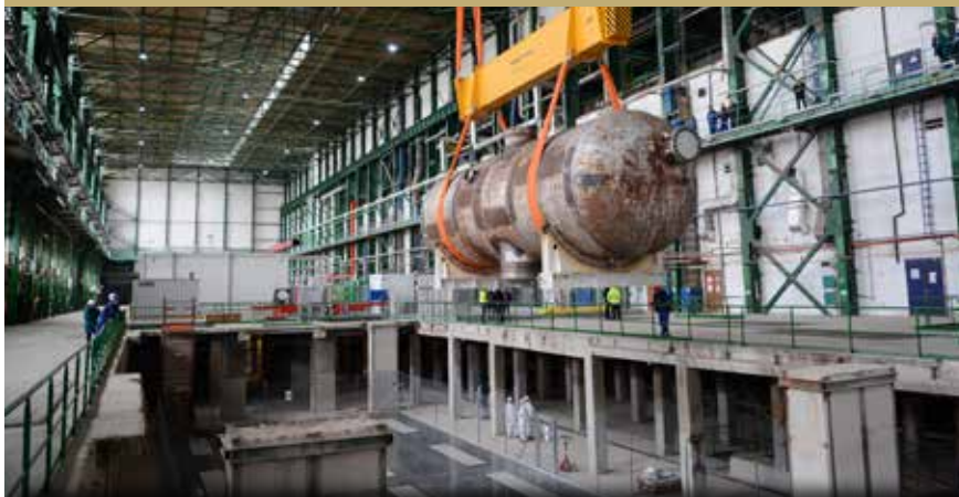
Po náročných manipuláciách je parogenerátor umiestnený v strojovni JE V1.
