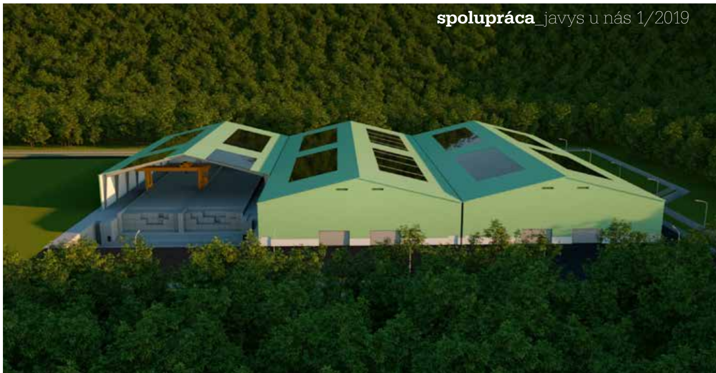
Vybudovaním tretieho dvojradu úložných boxov sa zvýši kapacita úložiska nízkoaktívnych RAO v Mochovciach na 10 800 vláknetónových kontajnerov.
