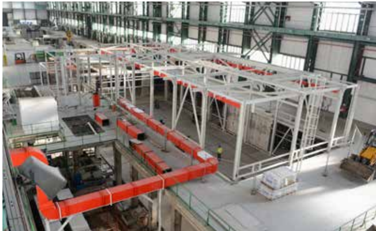
Výstavba pracoviska suchej fragmentácie v strojovni JE V1.
