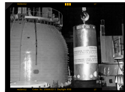
Zavážanie paliva pred fyzikálnym spúšťaním 1. bloku V1 v novembri 1978.
