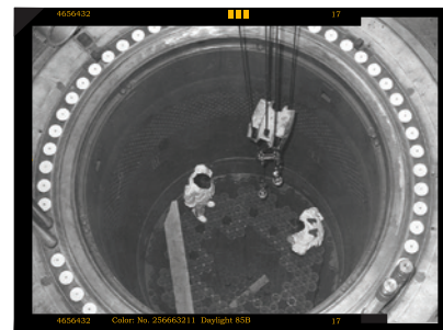
Zavážanie makiet palivových článkov do reaktora 1. bloku V1 pred III. hydrokúškou v októbri 1978.
