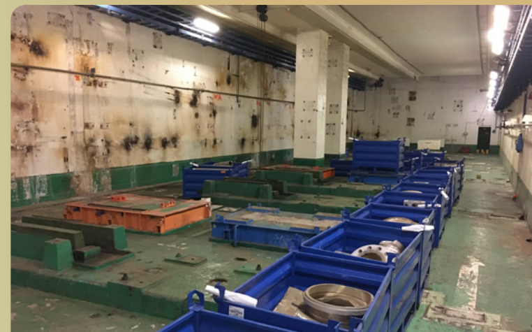
... po demontáži zariadení systémov havarijného doplnovania a sprchového systému.
