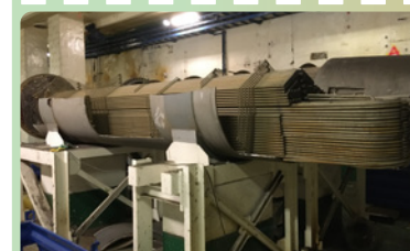
Demontáž tepel. výmenníka SS10T-1.
