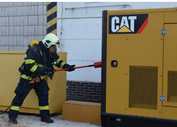
Počas havarijného cvičenia hasiči precvičovali simulovaný požiar dieselgenerátora.
