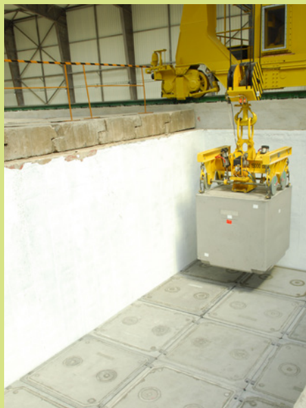
Ukladanie vláknobetónových kontajnerov s RAO na úložisko. Foto: Rastislav Prítrský
