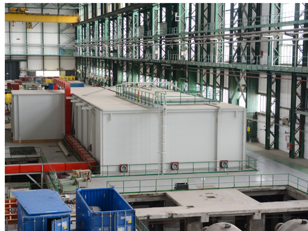
Pracovisko fragmentácie parogenerátorov vo vyraďovanej JE V1.
