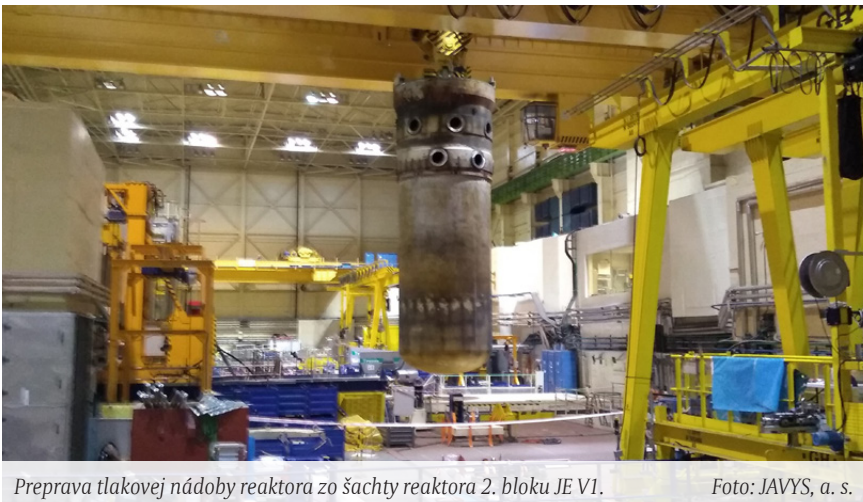
Tlaková nádoba reaktora so závesnými systémami váži 204 ton.
