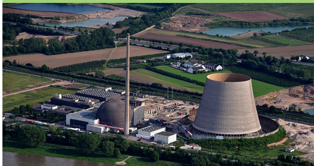
Elektrárň Mülheim-Kärlich na západe Nemecka.
