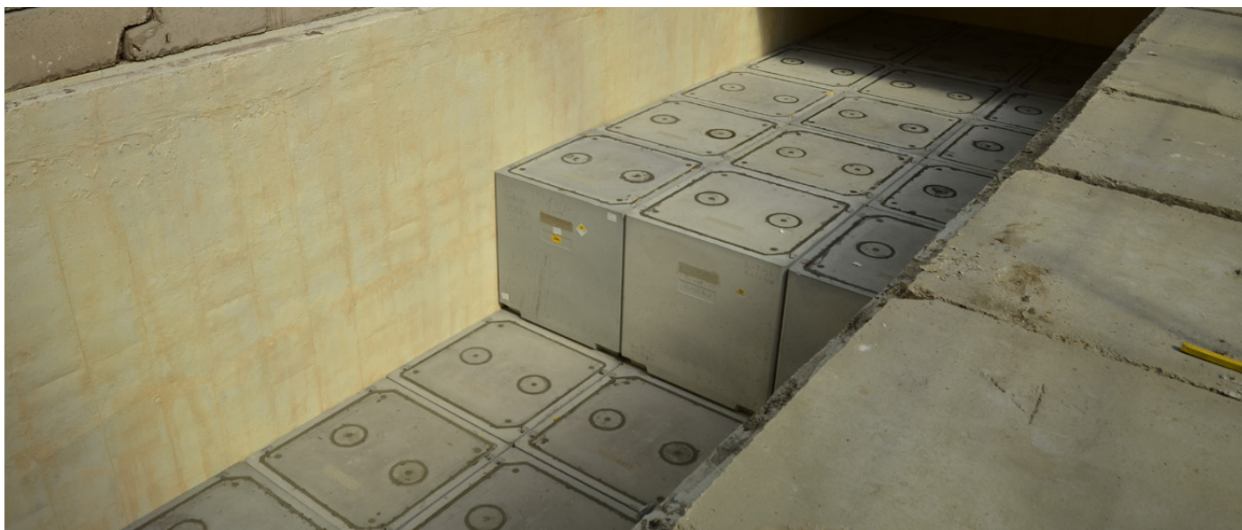
Vláknobetónové kontajnery s upravenými RAO v úložnom boxe Republikového úložiska RAO v Mochovciach.
