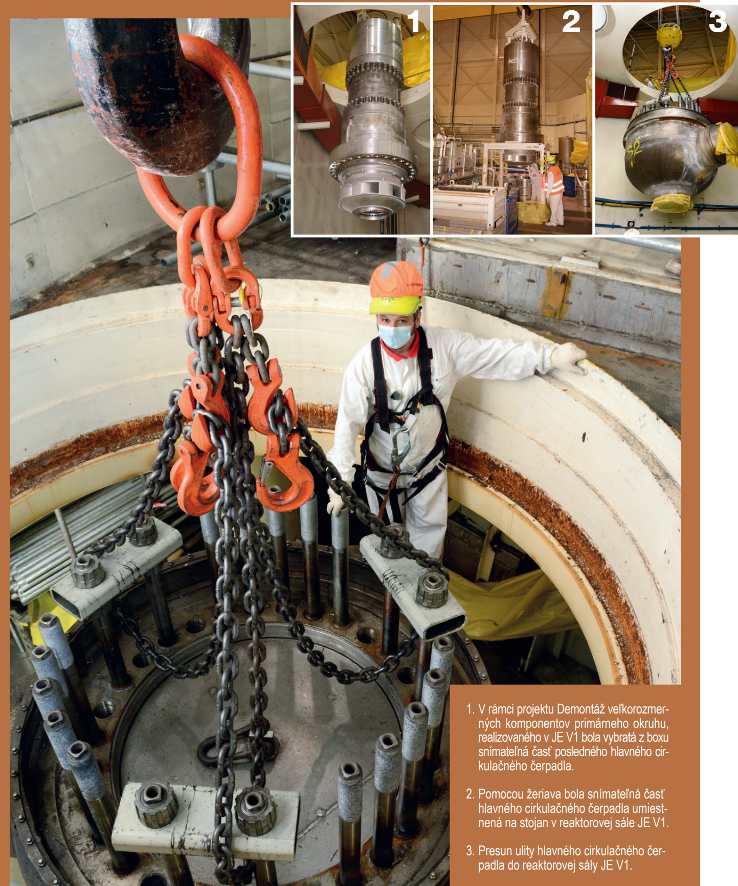
Príprava na zdvíhanie ulity posledného hlavného cirkulačného čerpadla z boxu.
