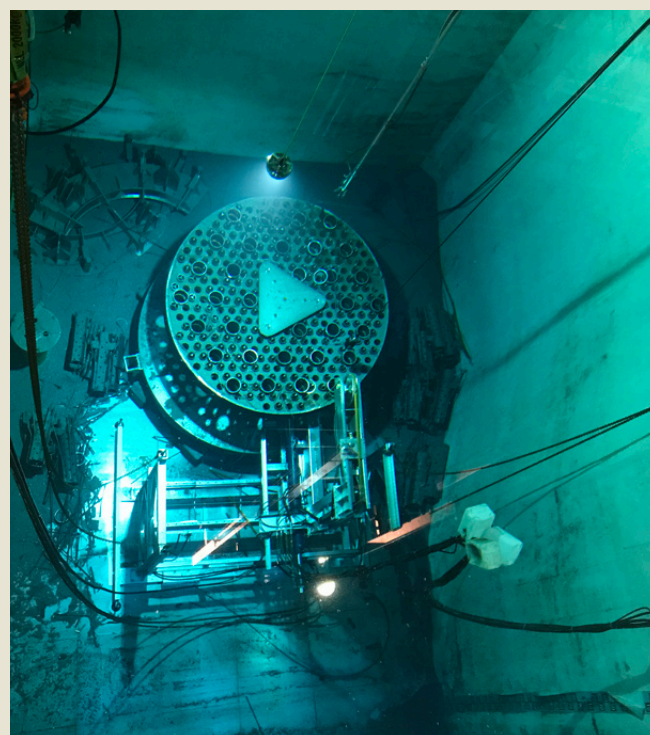
Vyradovacie činnosti v JE V1 - rezanie spodnej dosky bloku ochranných rúr v mokrom bazéne WCW (časť A).
