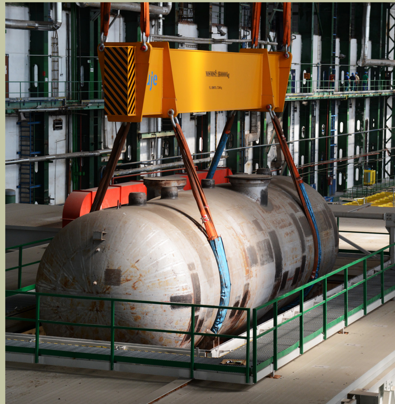
Preprava siedmeho parogenerátora na pracovisko suchej fragmentácie. Foto: Rastislav Prítrský
