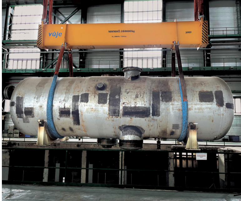
Transport posledného parogenerátora na fragmentačné pracovisko
