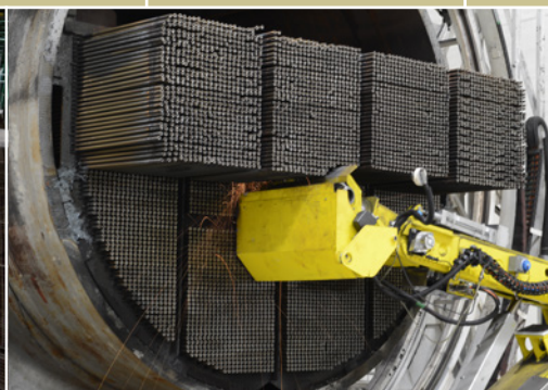
5. Fragmentácia teplovýmenných rúrok pomocou robotického ramena
