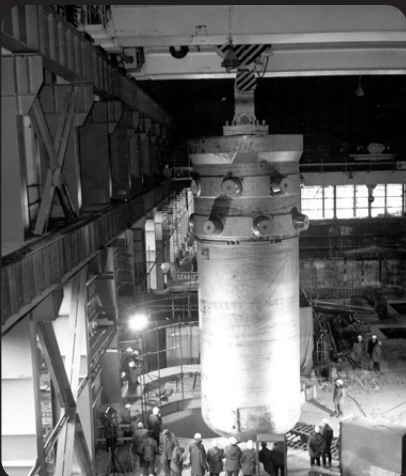
Transport tlakovej nádoby reaktora do šachty revízií – apríl 1977
