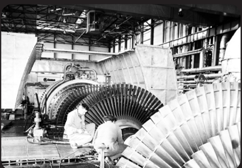
Rotor nízkotlakovej časti turbíny Škoda
