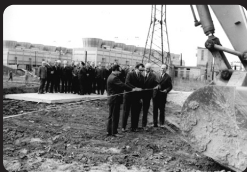
Slávnostné zahájenie výkopu základov hlavného výrobného bloku – 24. apríl 1973
