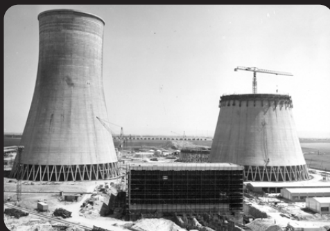
Chladiace veže a HČS (hlavná čerpacia stanica) – jún 1976
