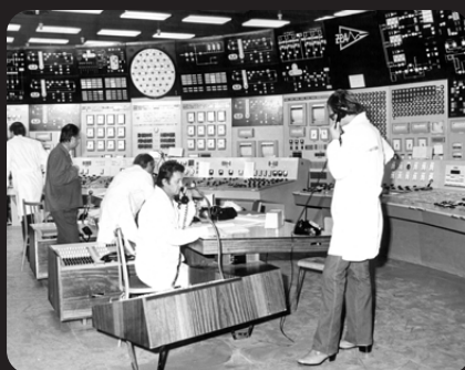
Bloková dozoriňa 1. bloku JE V1 – 17. december 1978
