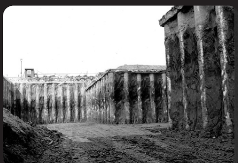
Vykopaná základová jama (Borové hospodárstvo I. blok) – september 1973
