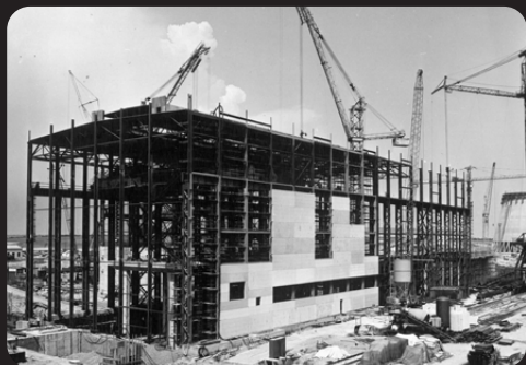
Strojovňa – siporexové obklady – august 1975
