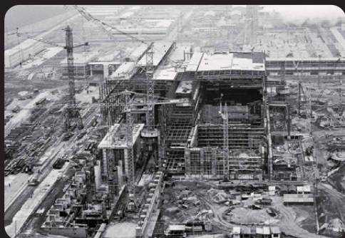
Výstavba hlavného výrobného bloku
