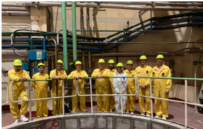
V reaktorovej sále Jadrovej elektrárne V1
