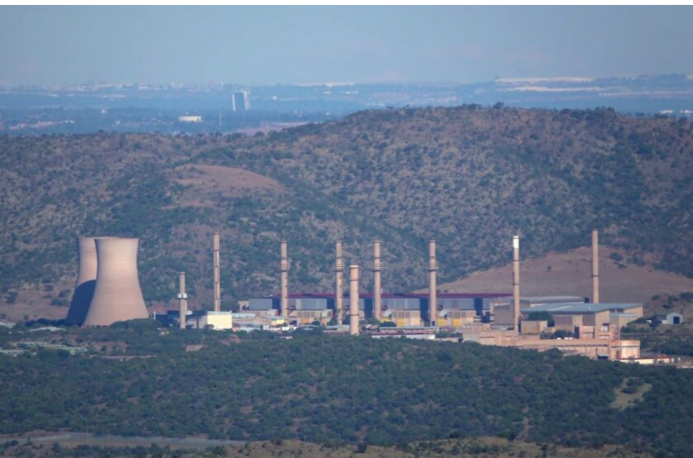
Historická budova závodu na obohacovanie uránu na lokalite NECSA.
