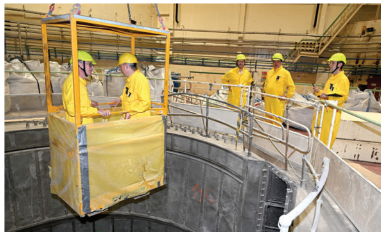
Delegácia pri spúšťaní do šachty reaktora 1. bloku JE V1. Foto: Rastislav Prítrský
