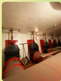
Armatury a potrubné trasy vzduchotechnického systému v hlavnom výrobnom bloku JE V1 pred a po demontáži
