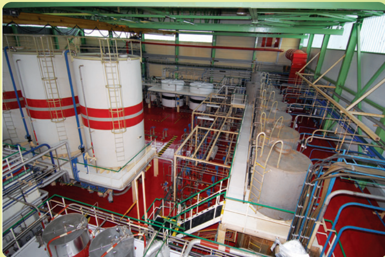
Nádrže systému prípravy chemických reagentov (PR) v budove pomocných prevádzok pred a po demontáži
