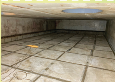
Miestnosť v budove pomocných prevádzok po demontáži oblicovky
