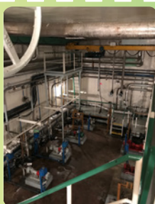
Čerpadlá a potrubné trasy systému čistého kondenzátu v budove pomocných prevádzok pred a po demontáži
