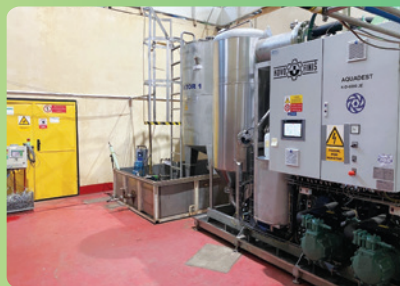
Mobilná vákuová odparka AQUADEST pre spracovanie odpadových vôd z kontrolovaného pásma JE V1
