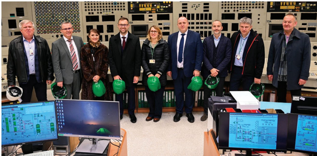
Zástupcovia MH SR v blokovej dozorni JE V1
