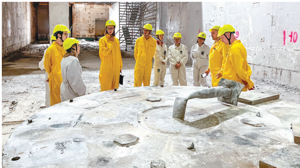
Študenti pri demontovanej oceľovej konštrukcii z univerzálneho hniezda bazény skladovania vyhoretého paliva
