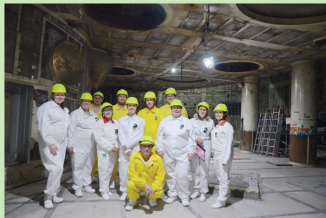
Účastníci workshopu v boxe parogenerátorov a hlavných cirkulačných čerpadel JE V1.
