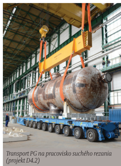
Vyberanie parogenerátora (PG) z boxu PG a hlavných cirkulačných čerpadí (projekt D4.2)
