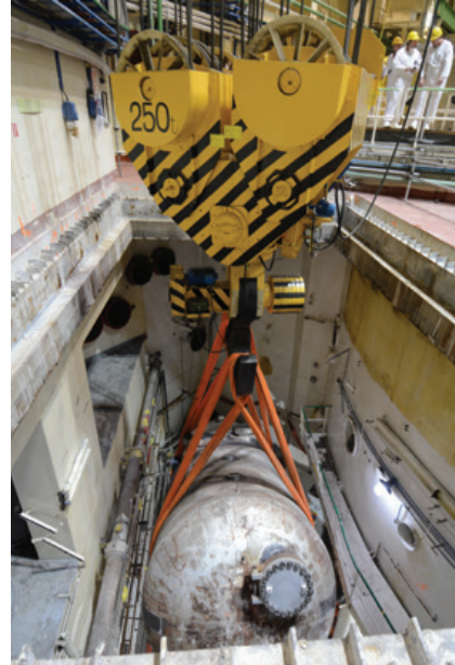
Vyberanie parogenerátora (PG) z boxu PG a hlavných cirkulačných čerpadí (projekt D4.2)
