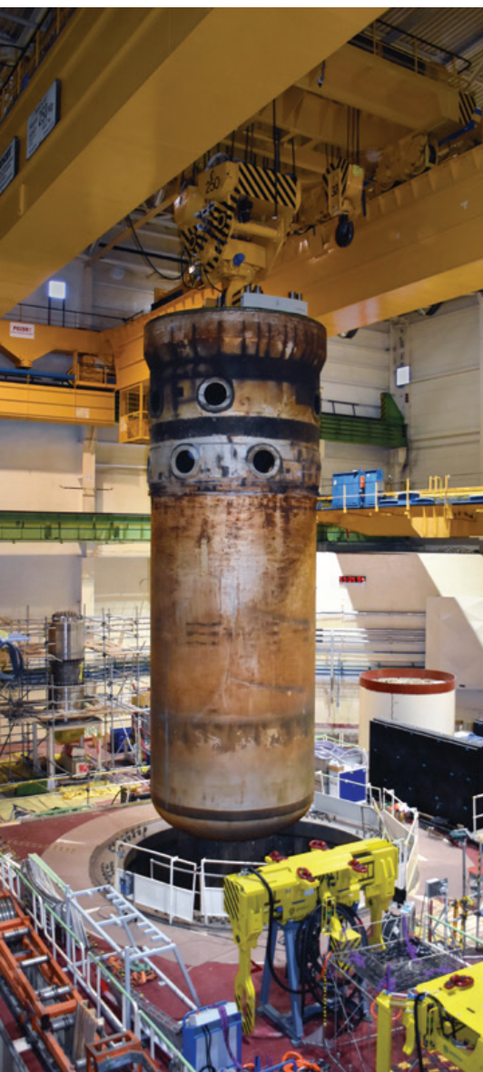
Transport tlakovej nádoby reaktora do pracoviska mokrého rezania (projekt D4.2)
